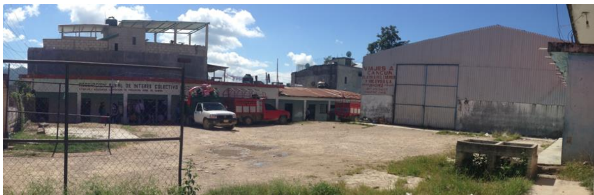
Imagen núm. 11. Instalaciones de la ARIC histórica, albergue de sus militantes desplazados en 1994. Fotografía propia tomada a finales de 2013.
