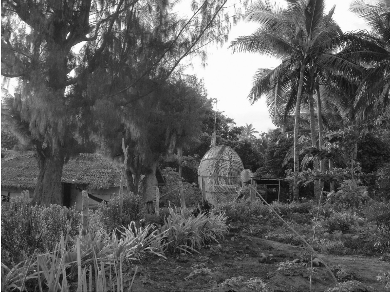
El repetidor de microondas, ya inservible y rodeado de vegetación. (Foto: C. Mondragón, 2012)
