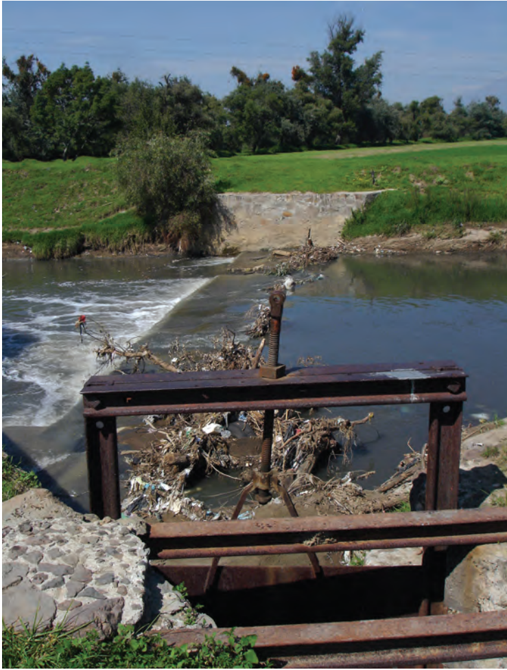
Fotografía 17. Compuerta de la presa del río Atoyac, ejido de Nativitas.
