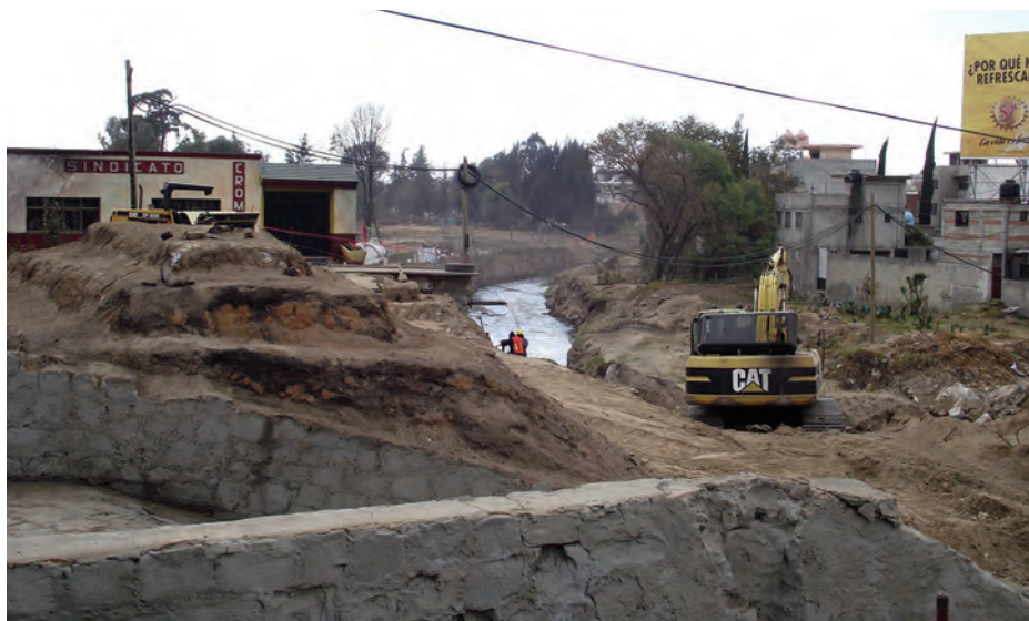
Fotografía 8. Trabajos después de la explosión del ducto de Pemex y derrame de petróleo en el río Atoyac en San Martín Texmelucan, Puebla.
