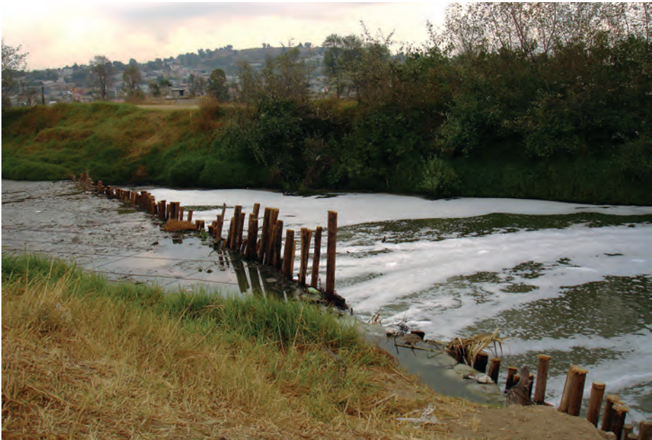
Fotografía 18. Presa del ejido de Tepactepec, río Zahuapan.
