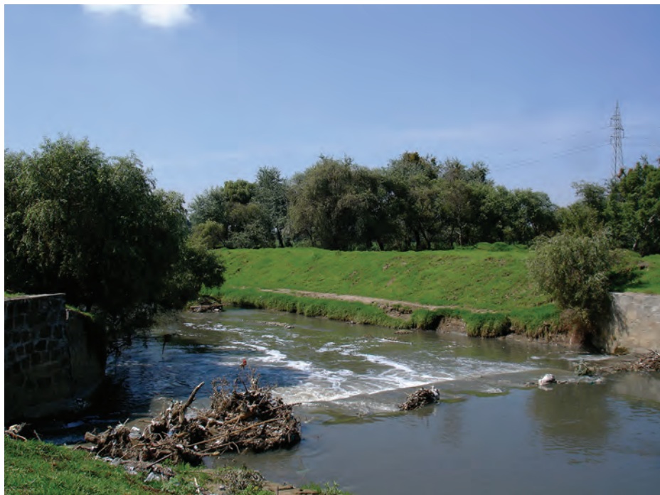
Fotografía 16. Lugar donde se instala la presa del ejido de Nativitas, río Atoyac.
