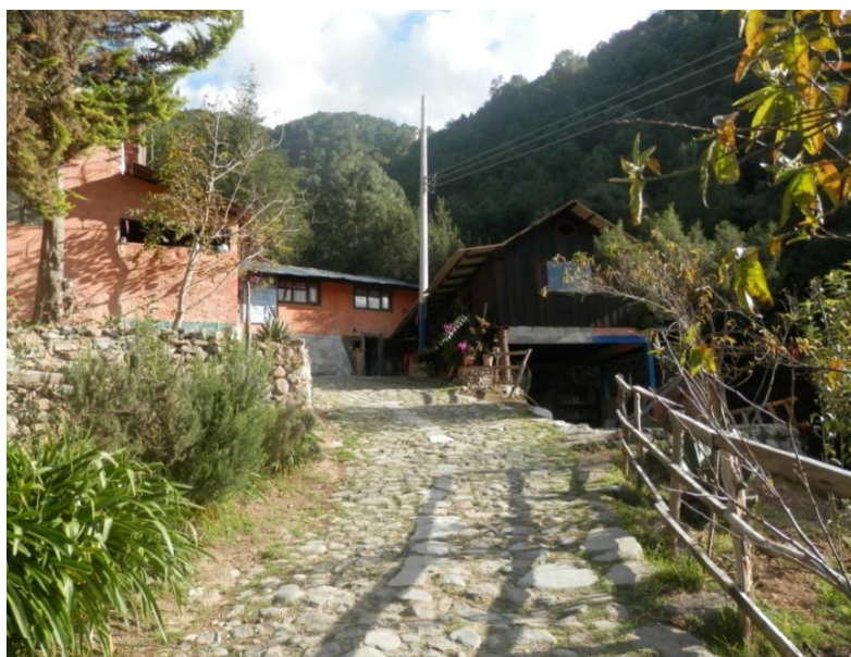
Figura no. 9. El internado-bachillerato de San Andrés Tepexoxuca. Octubre 2014, autoría propia.
