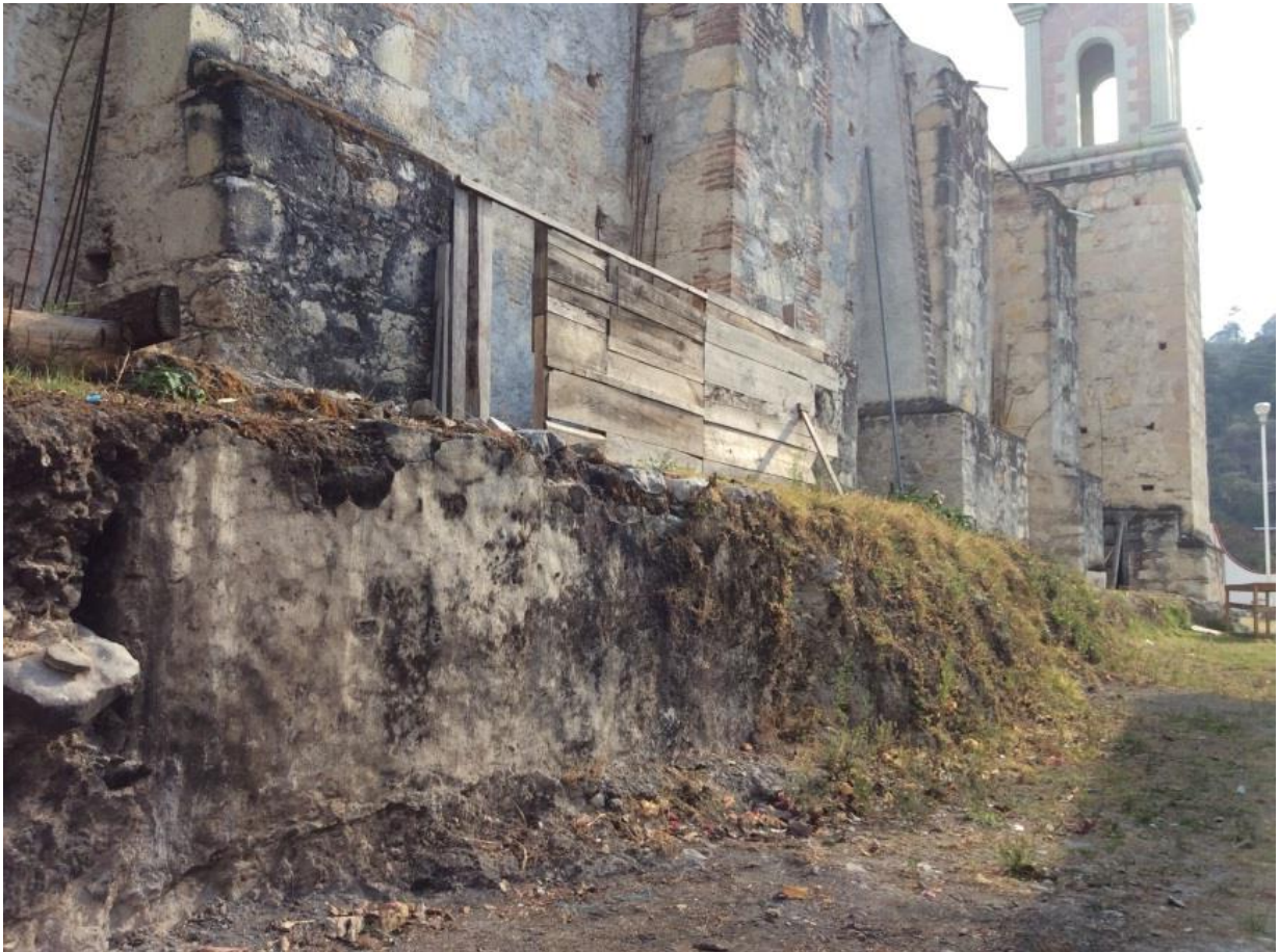
Fig. 38: Podemos ver el muro de la estructura precolonial sobre la cual se construyó el templo católico.
