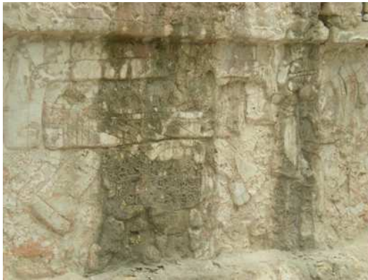
Ilustración 22: Sección húmeda con biofilm y karstificación.
