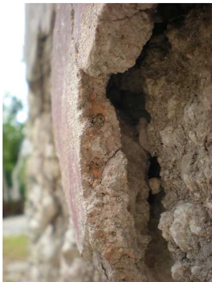
Ilustración 109: Capa rojo anaranjado en los bordes de las roturas en los estucos. Fotografía: Luisa Straulino.
