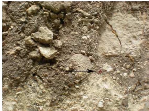
Ilustración 12: Estuco con capa pictórica reutilizado en repellado grueso. Fotografía: Luisa Straulino
