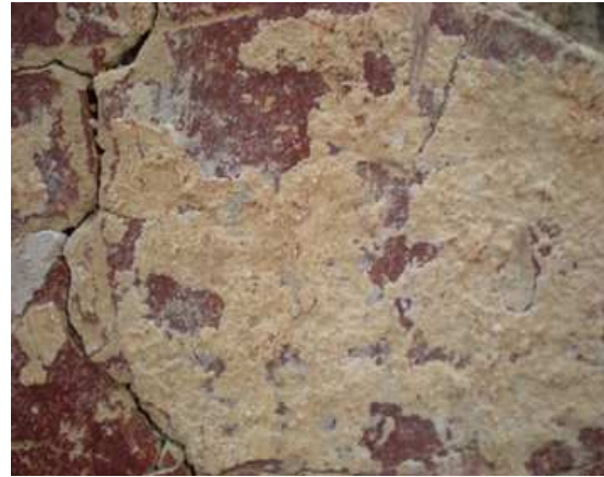
Ilustración 10: Repellado posterior con pigmento naranja muy deteriorado. Fotografía: Luisa Straulino
