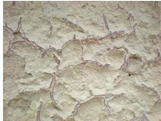
Ilustración 23: Deterioro en forma de red por disolución y pulverización por sales.
