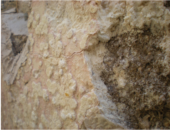
Ilustración 9: Repellado interior del edificio este, Pequeña Acrópolis. Fotografía: Luisa Straulino
