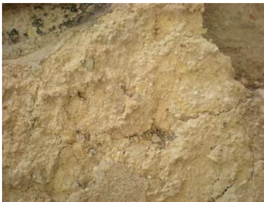
Ilustración 13: Superficie rugosa y pulverulenta. Repellado del interior del edificio este, Pequeña Acrópolis. Fotografía: Luisa Straulino.
