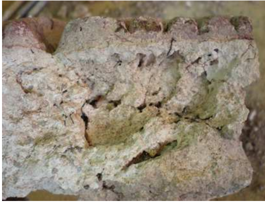
Ilustración 17: Sección transversal, pueden verse diversas capas de estuco que forman la figura. Fotografía: Luisa Straulino.
