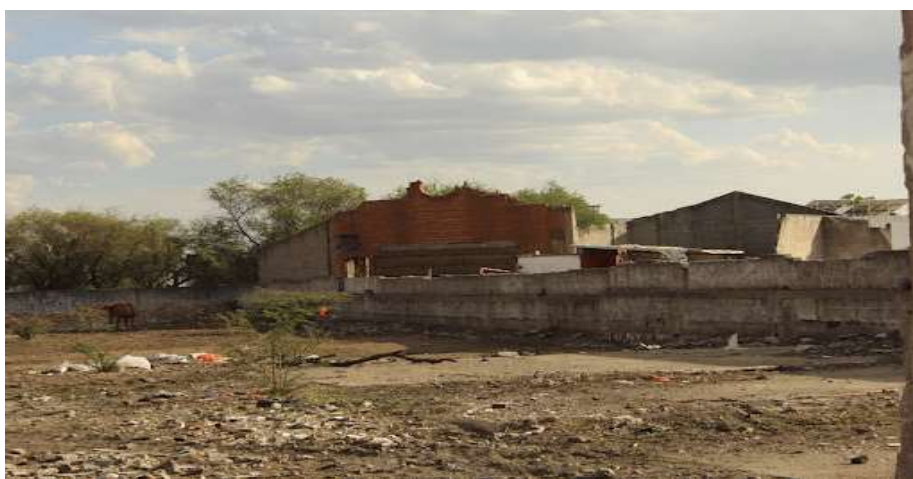
Fotografía 29. Remanente del casco de un edificio del poblado “El Ranchito” Archivo personal. Tomada por Alba Díaz el 7 de Agosto del 2023
