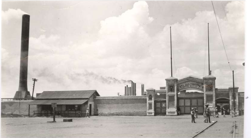
Fotografía 2. Entrada a la Gran Fundición Central Mexicana (s. f.). Archivo Histórico del Instituto Cultural de Aguascalientes, fototeca Alejandro Topete del Valle.
