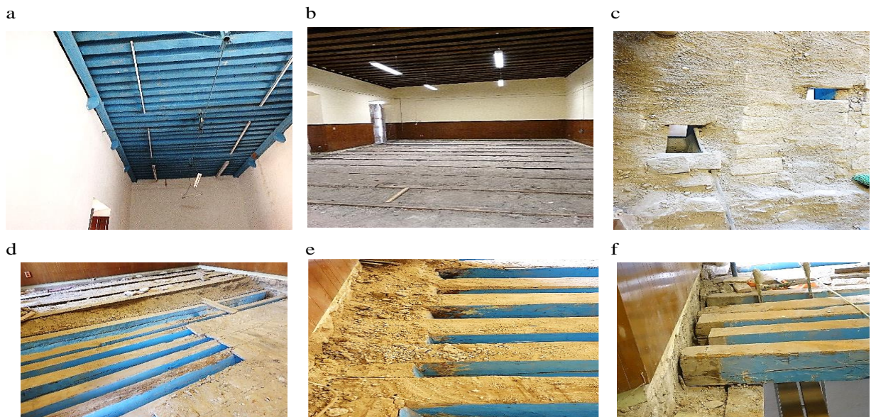
Figura 12. 7. Vigería del cuarto azul antes de ser retirado (a), después de retirar la duela superior (b), retiro del terrado (c), de enladrillado (d y e) y desmonte de vigas (f) del entrepiso.
