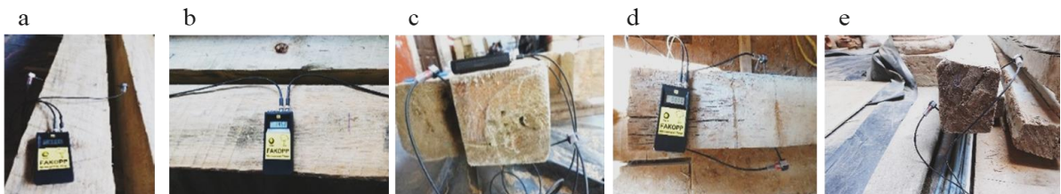
Figura 12. 17. Mediciones de la vigería sana (a, b y c) y deteriorada (d y e) con el equipo Fakopp.
