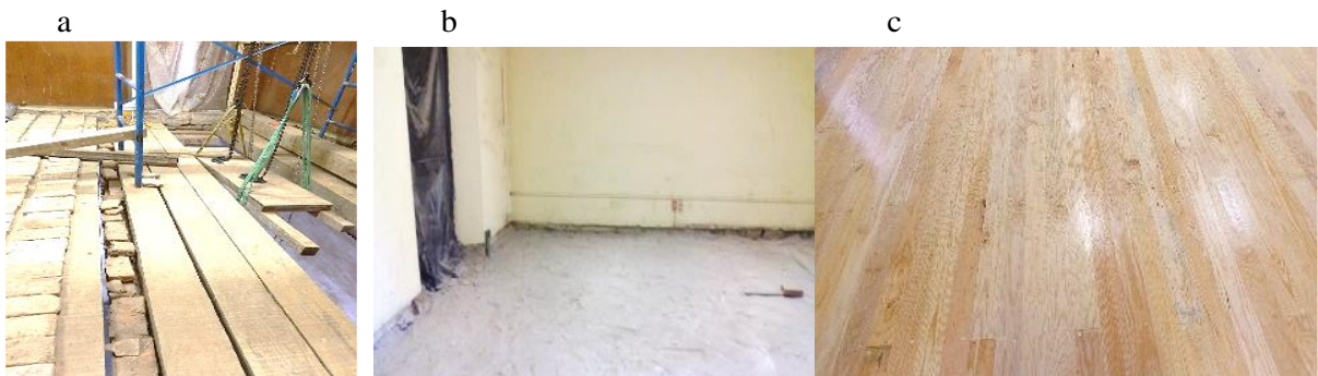
Figura 12.48. Vigería nueva siendo colocada (a, b y c).
