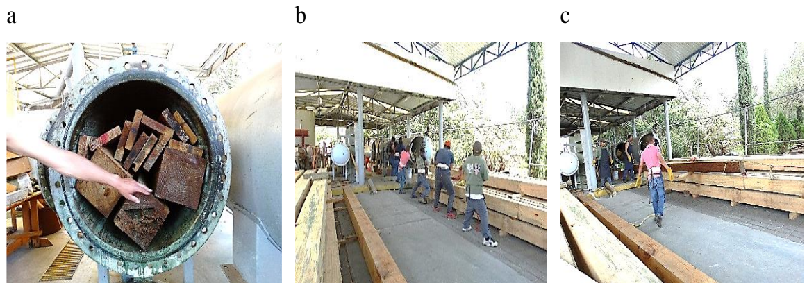
Figura 12. 9. Viguería de madera de reciente corta antes del tratamiento de preservado (a), viguería siendo retirada del tanque de vacío posterior al tratamiento (b y c).
