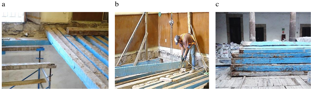
Figura 12. 6. Vigería del cuarto azul al momento de estar siendo desmontadas del edificio (a y c) y su colocación en el patio una vez que fue retirada (c).
