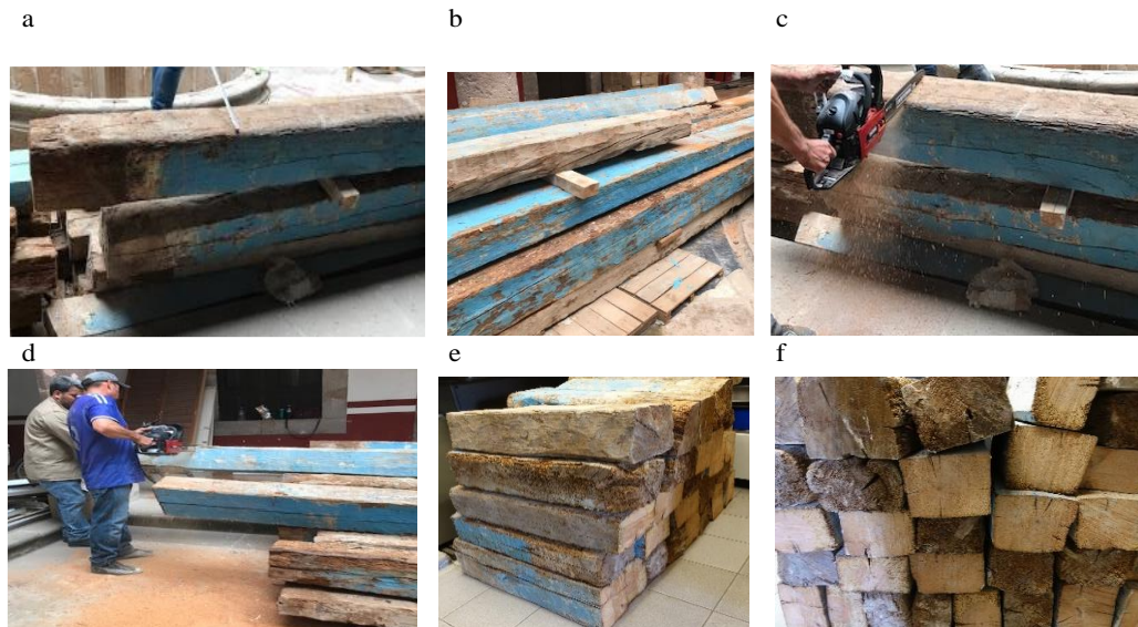
Figura 12.11. Material de donación del Edificio conocido como Palacio Federal, selección y medición de vigas (a y b), corte de las secciones de donación (c y d), cabezas ya cortadas y almacenadas (e y f).
