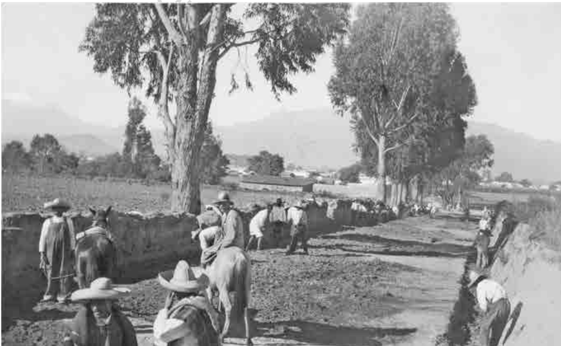
Fotografía 5. Construyendo caminos, Xocoyucan. Archivo General de la Nación, México Contemporáneo, Dirección de Misiones Culturales.
