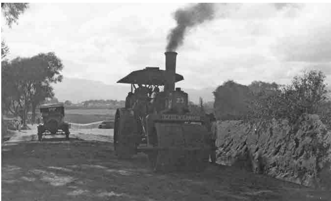
fotografía 6. Construyendo caminos, Xocoyucan. Archivo General de la Nación, México Contemporáneo, Dirección de Misiones Culturales.
