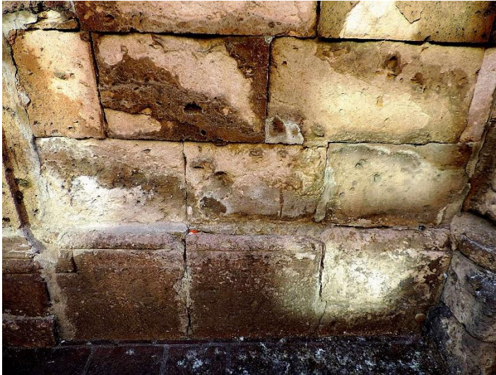
Fig. 23. Cristalización de sales en ignimbrita, inmueble ubicado en calle Galeana, Morelia, Michoacán, México. Fuente: Aldo Zamudio Pérez, 2015.
