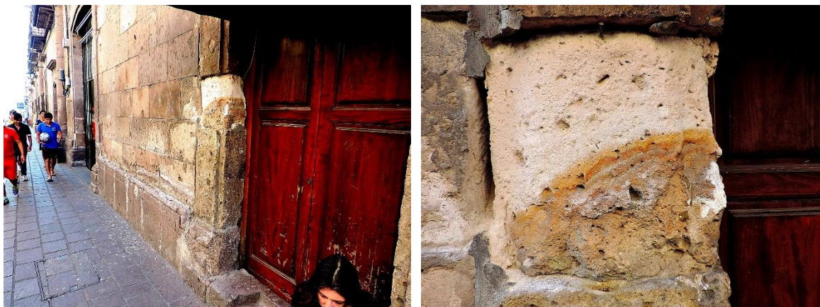
Fig. 22. Cristalización de sales en jamba de ignimbrita, inmueble ubicado en calle Galeana, Morelia, Michoacán, México. Fuente: Aldo Zamudio Pérez, 2017.
