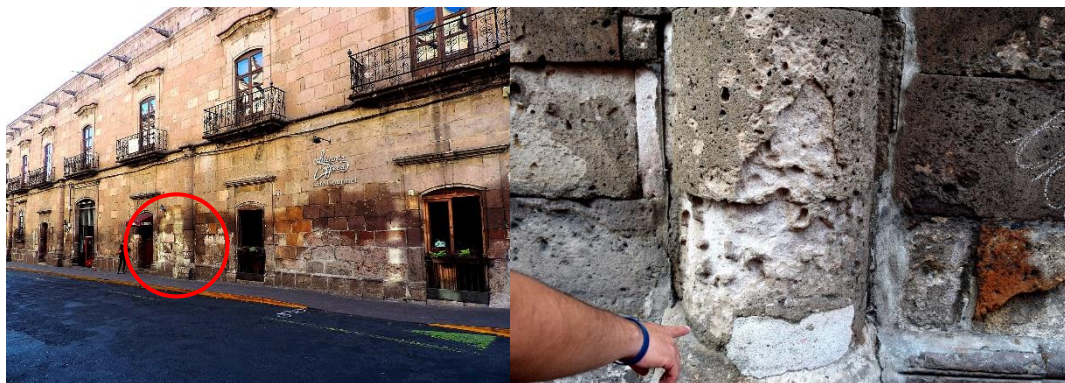
Fig. 45. Muestra ignimbrita del banco de Arindeo en mamposterías de calle Galeana en Morelia Michoacán. Fuente Aldo Zamudio Pérez, 2017.
