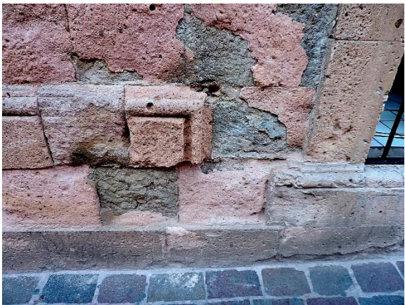
Fig. 18. Disgregación sacaroidea en ignimbrita de inmueble ubicado en Av. Morelos Norte, Morelia, Michoacán, México. Fuente: Aldo Zamudio Pérez, 2017.
