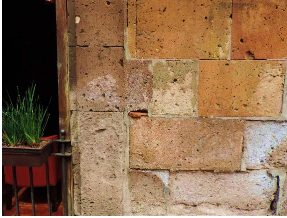
Fig. 20. Disyunción de películas, disgregación y descamación en la ignimbrita de inmueble ubicado en calle Galeana, Morelia, Michoacán, México. Fuente: Aldo Zamudio Pérez, 2017.
