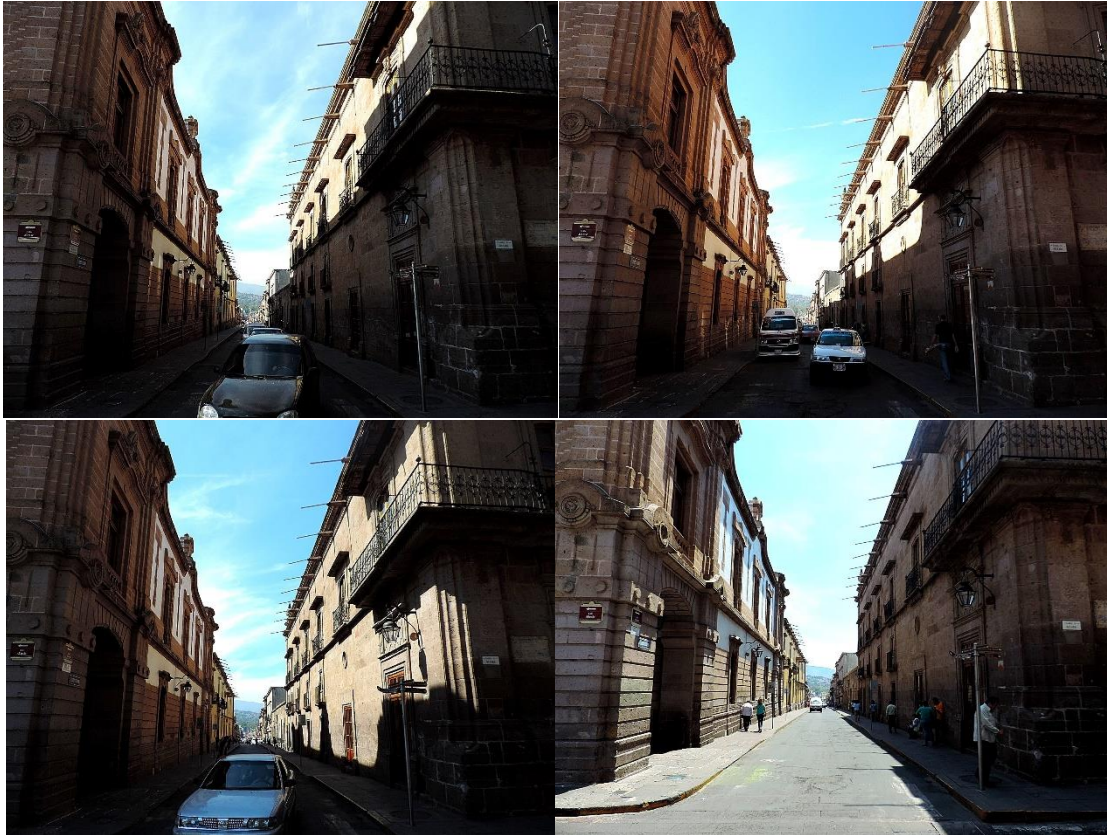
Figura 5-8: Asoleamiento en fachadas principales, calle Abasolo, Morelia, Michoacán, México. Fuente Aldo Zamudio Pérez, 2015.
