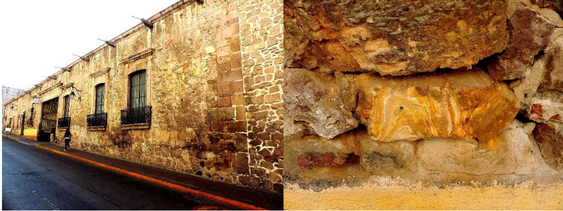
Fig. 06. Deterioro de ignimbrita en fachada principal de inmueble ubicado en calle Guillermo Prieto, Colonia Centro, Morelia, Michoacán, Mx. Fotografía Aldo Zamudio Pérez, 2016.
