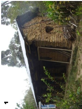
1. Vista exterior del volumen que ocupaba inicialmente la cocina, actualmente utilizado como depósito. Los muros están contruidos con mampostería en piedra y se ha reemplazado el manto de cubierta original; 2. Acceso a la cocina, que tiene una galería de permanencia y circulación que hoy en día se usa para el acopio de materiales de construcción y objetos de uso doméstico; 3. Fachada norte del volumen que ocupaba la cocina
