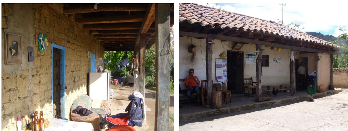
Ilustración 43. Galería de una vivienda del municipio de Sutamarchán (izq) y galería de una vivienda a del municipio de Ráquira, en cuyo extremo se construyó un volumen (der).
