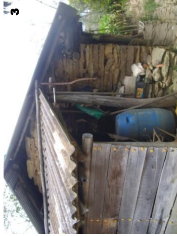
1. Vista exterior del volumen que ocupaba inicialmente la cocina, actualmente utilizado como depósito. Los muros están contruidos con mampostería en piedra y se ha reemplazado el manto de cubierta original; 2. Acceso a la cocina, que tiene una galería de permanencia y circulación que hoy en día se usa para el acopio de materiales de construcción y objetos de uso doméstico; 3. Fachada norte del volumen que ocupaba la cocina
