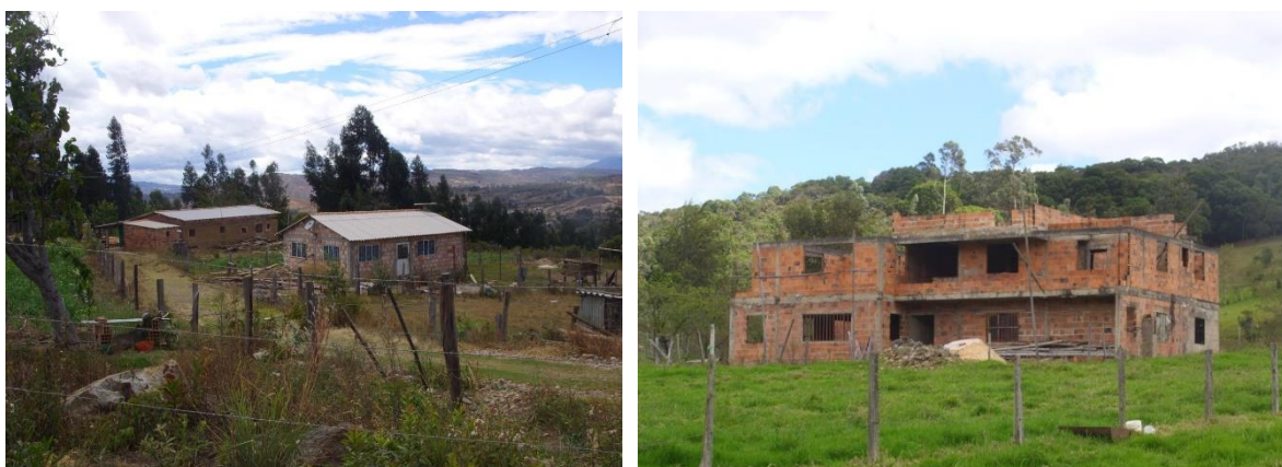
Ilustración 74. Viviendas construidas con materiales industrializados en Ráquira (izq.) y Gachantivá (der.)
