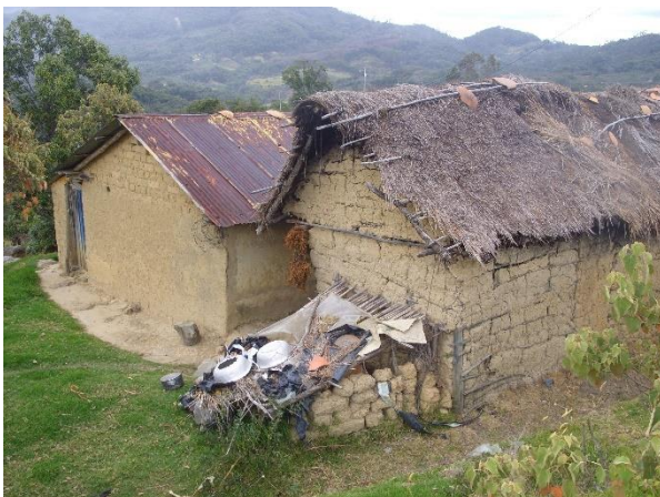
Ilustración 66. Primer momento de hibridación. Reemplazo de materiales de cubierta en una vivienda en el Bosque Húmedo de Ráquira.
