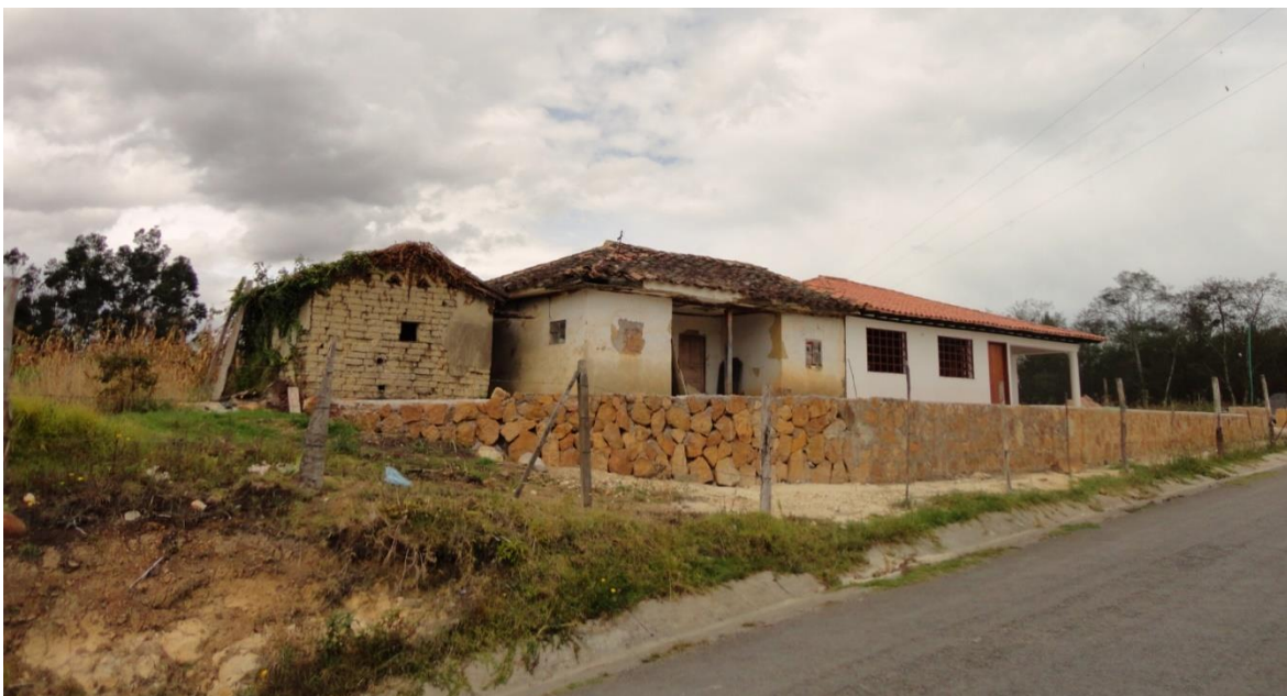
Ilustración 83. Vivienda sobre la vía que comunica los municipios de Villa de Leyva y Gachantivá; en ella se observan tres etapas constructivas. En la actualidad, un muro perimetral impide la observación de los inmuebles.
