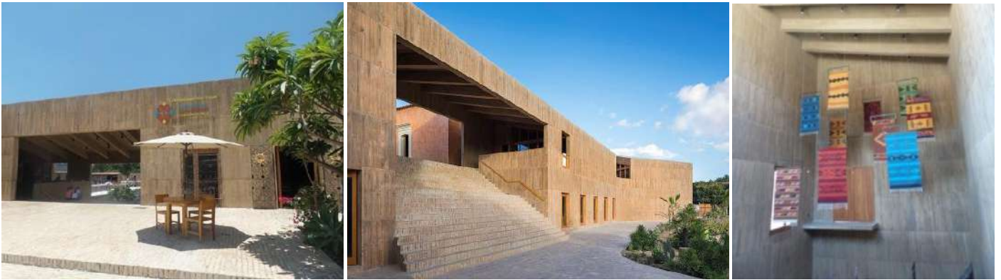
Fachada del CCCTV e instalación de textiles en cubo de la escalera principal. (Fotos: Mariana Almaraz, Teotitlán del Valle, 2019)
