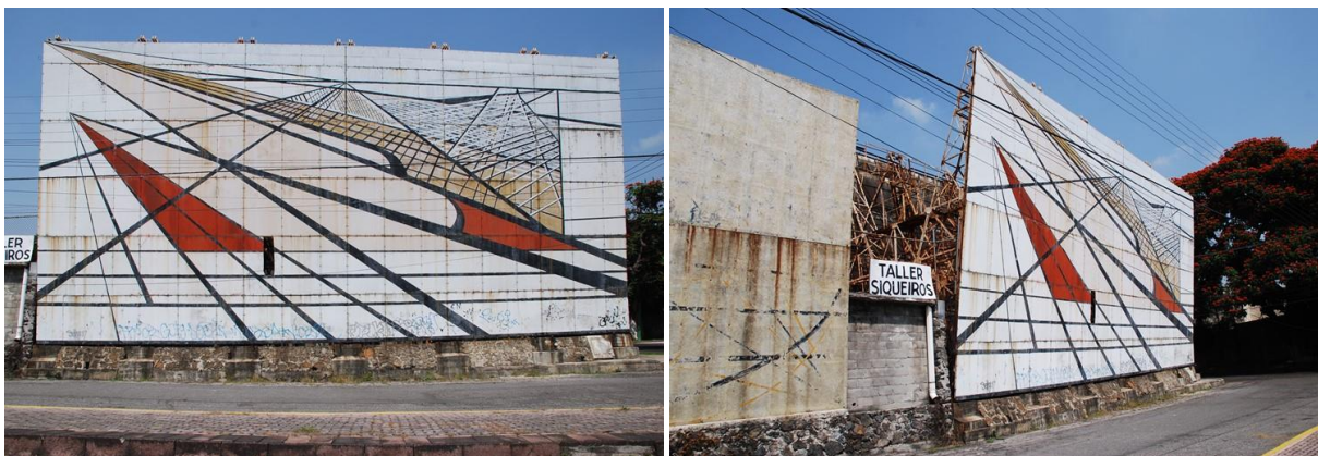
Figura 5. Mural N°3 exterior de La Tallera (1964-1965) de David Alfaro Siqueiros previo al desmontaje. Fotografías proporcionadas por el Taller de Pintura Mural del CENCROPAM-INBA
