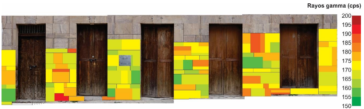
Figura 54. Rayos gamma (cps) medidos en la Casa de cantera. El bloque con el valor más alto se ubica en la parte inferior. Es notable que los valores altos se distribuyen por toda la construcción, pero están condicionados por su litología.
