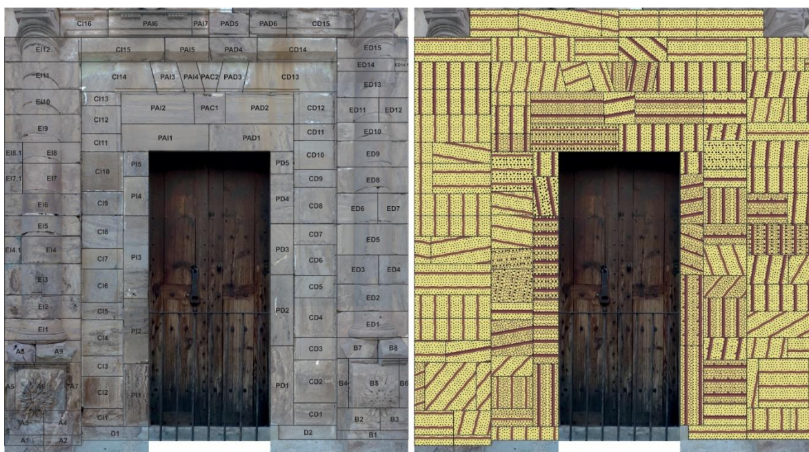
Figura 45. Izquierda: nomenclatura asignada a los bloques que componen la entrada este del Centro Cultural. Derecha: resultados del mapeo litológico detallado en el que se incluye además la orientación de las estructuras en los bloques. Leyenda del tipo de roca en la Figura 46.
