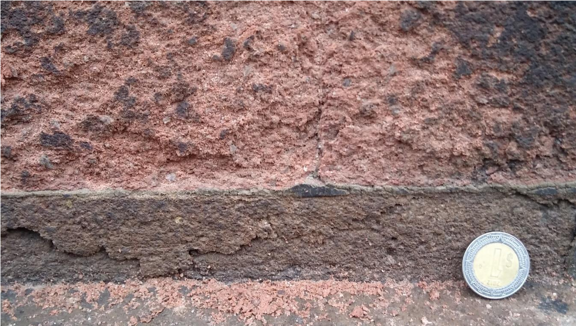
Figura 25. Disgregación de la roca en conjuntos o granos individuales. Generalmente cuando existe este daño se encuentran depósitos del mismo material en la parte inferior. Centro Histórico de San Luis Potosí.
