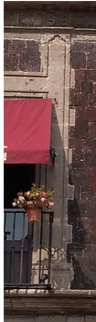
Imagen LXXIX. Dentellado de la cantera con la mampostería en jamba, casa de las Sirenas. Fuente: fotografía RGM:
