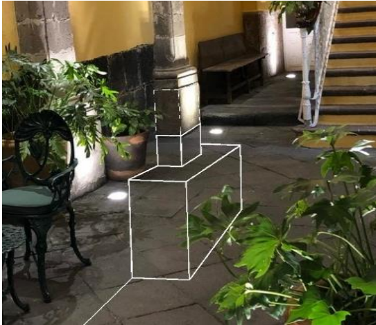
Imagen LVI. Cimentación hipotética de las pilastras empotradas a muro. Casa VII (de las Sirenas). Fuente: elaboración propia.
