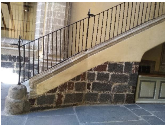
Imagen LVII. Primera sección de escalera, Casa II (Seminario #12). Fuente: fotografía RGM.
