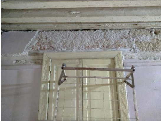
Imagen LXIV. Muro de divisorio de tepetate. Fuente: fotografía RGM.
