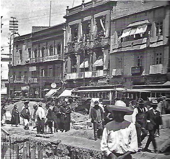
Imagen CVII. Excavación para la instalación de la fuente de fray Bartolomé de las Casas en la calle de Seminario, ca. 1923 (fragmento). Fuente: Sánchez Reyes, Gabriela (2019). Origen y desarrollo de la Plaza del Seminario. México: INAH, pág.146.
