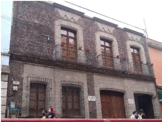
Imagen XL. Casa Tlaxcala, se puede apreciar la disminución del ancho y número de los vanos
