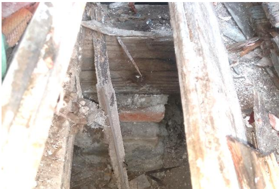
Imagen CV. Sistema para recibir la duela de madera. Fuente: fotografía RGM.
