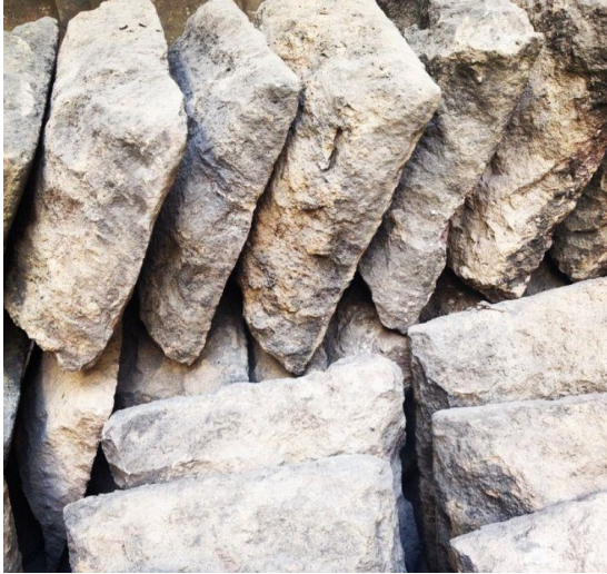
Imagen CIV. Sillares de piso enconchado. Fuente: fotografía CON.
