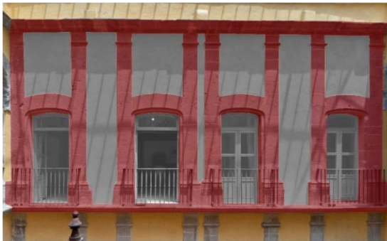
Imagen LXXV. Enmarcamientos en forma de H, ligados a cornisa superior e inferior; casa Borda. Fuente: dibujo propio sobre fotografía de Airbnb, tomada de https://www.airbnb.mx/users/show/3285196?_set_bev_o_n_new_domain=1615230686_YmQxZGVINW11Nzdi
