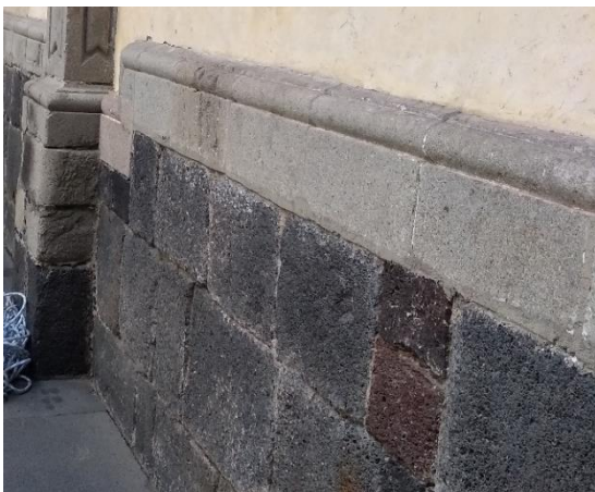
Imagen LXIII. Rodapié de tezontle y cantera gris de los remedios, Casa del Seminario #12. Fuente: fotografía RGM.
