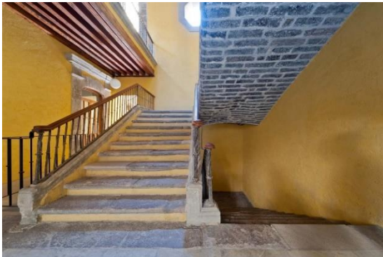
Imagen LXXXV. Caja de escaleras de la casa Borda. En la rampa de la derecha puede verse el intradós con sillares de tezontle careados. Fuente: Airbnb, tomada de https://www.airbnb.mx/users/show/3285196?_set_bev_o_n_new_domain=1615230686_YmQxZGVlNWl1Nzdi
