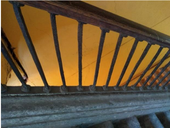
Imagen XLIX. Barandal de hierro forjado, Casa I, Seminario #12. Fuente: fotografía RGM.
