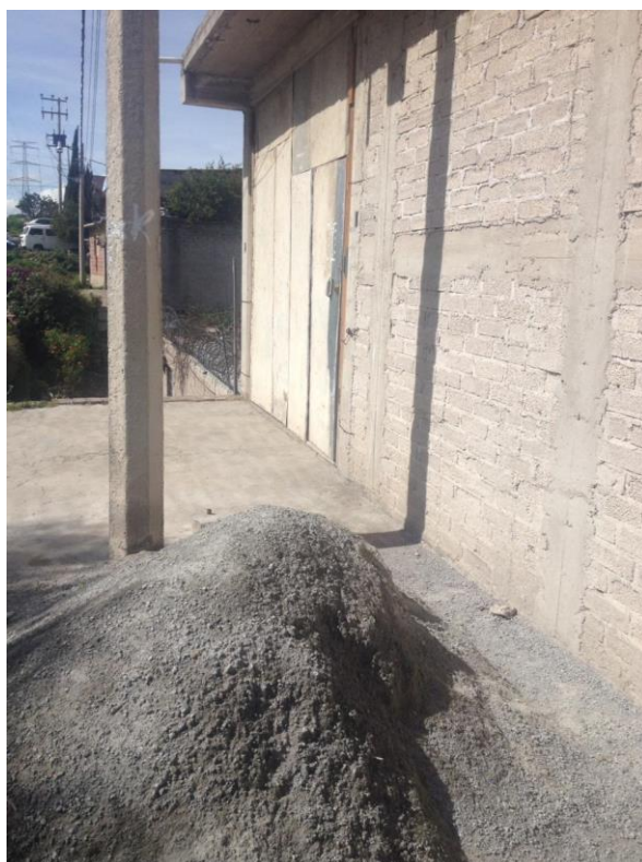
Ilustración 8 Frente de la casa de Lucila con material de construcción. Colonia Techachaltitla. 14-10-2018. Foto: Magali Marega
